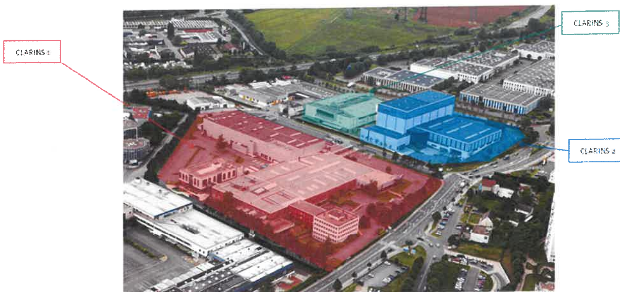
Figure 1 : Vue aérienne du site des Laboratoires CLARINS
