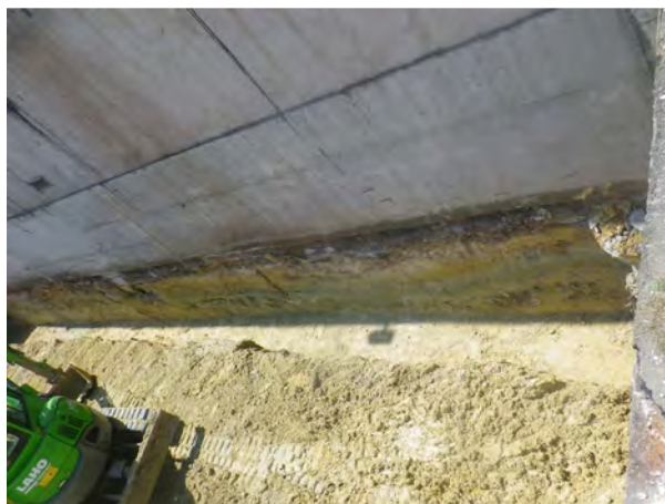
Photographie 4 : Terrassement final de la fouille SC1
