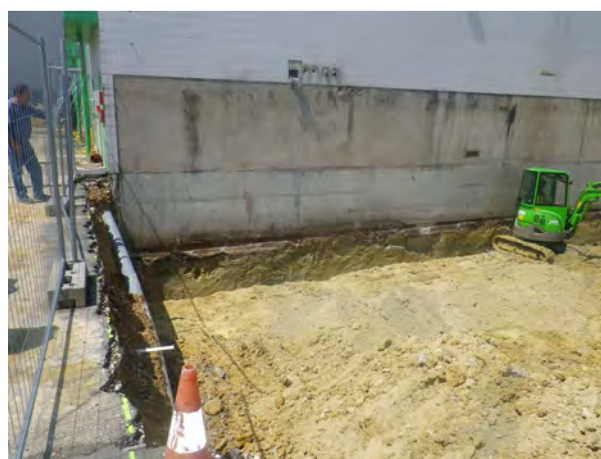
Photographie 6 : Vue de la fouille SC1 par rapport au bâtiment
