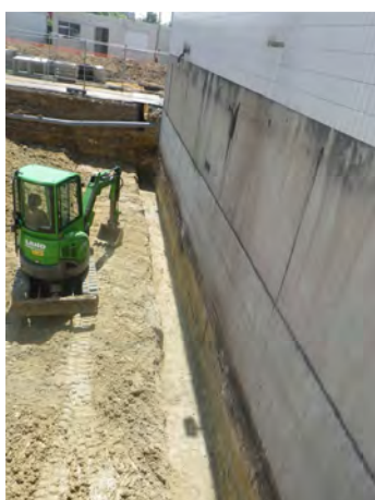
Photographie 5 : Vue de la fouille SC1 par rapport au bâtiment
