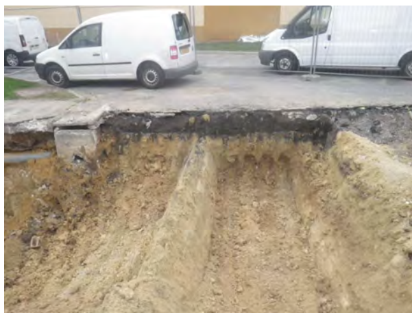
Photographie 2 : Localisation de la canalisation – zone S2
