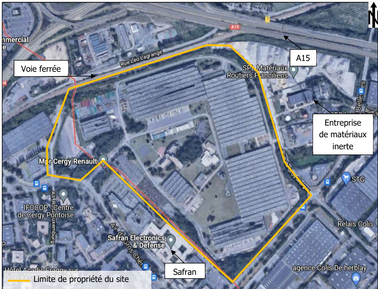
Figure 2 : Vue aérienne du site et de son environnement 2
