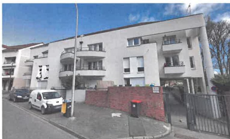
11 rue du Pressoir – Villiers-le-Bel
