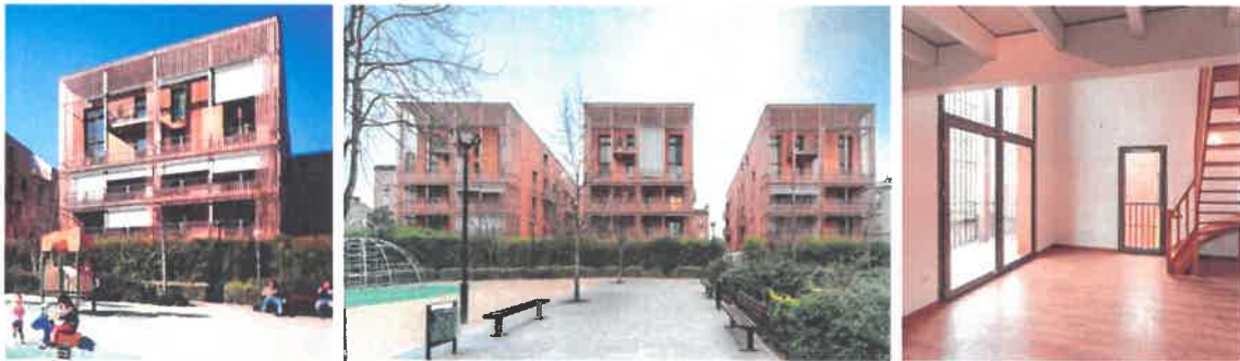
Tectone - ZAC Auvry -- 39 logements - Aubervilliers (93)
