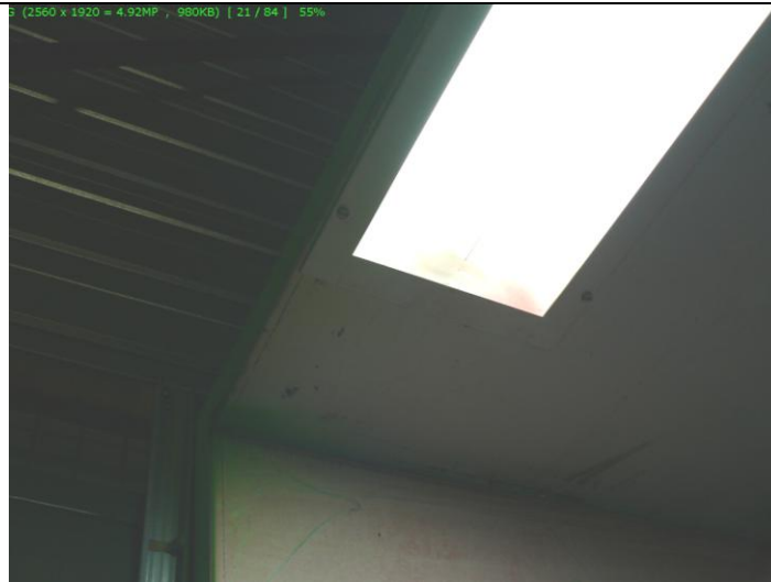
L'éclairage s'effectue à travers une vitre étanche en toiture de la cabine – L'installation électrique est extérieure à la zone de pulvérisation.
