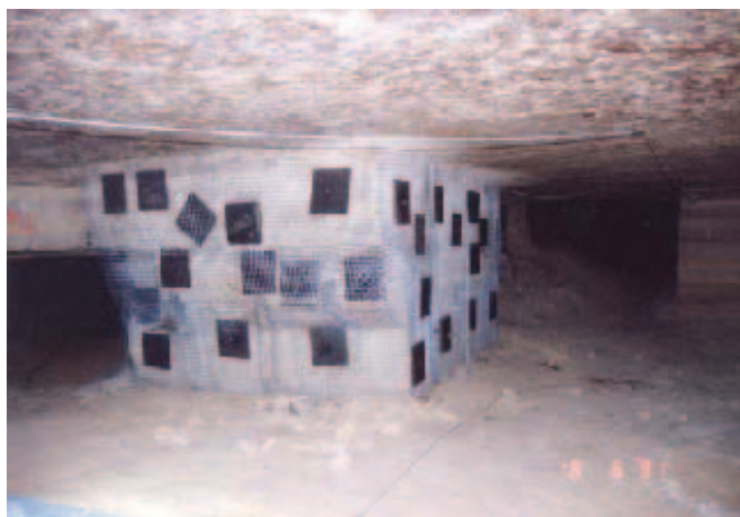
Photo 8 : Pilier renforcé par grillage et boulonnage (carrière de la Brasserie, Vincennes)
