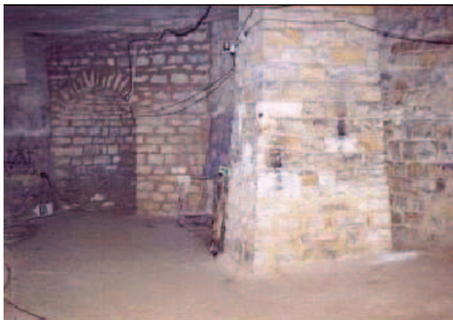
Photo 6 : Consolidation par piliers maçonnés (carrière de la Brasserie, Vincennes)
