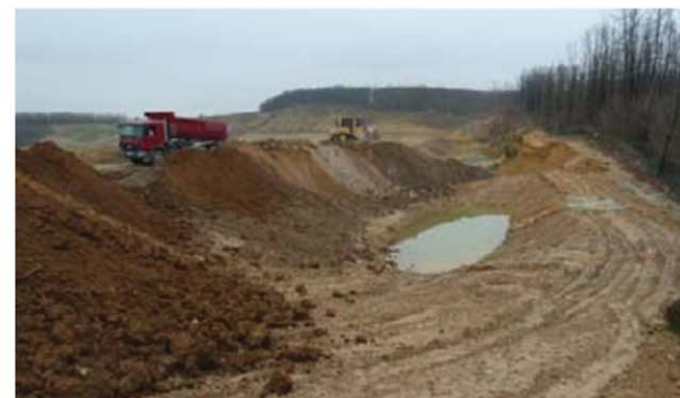
Terrassement d'un bassin de régulation
