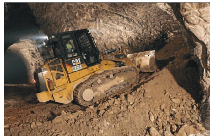
Remblayage total des galeries d'extraction en souterrain (carrière de Montmorency)
