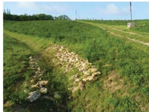
Collecte des eaux par des fossés et traitement par des fosses de décantation
