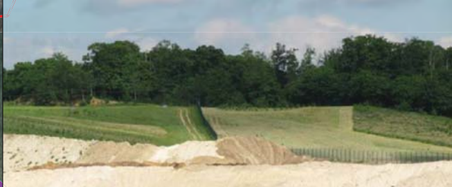
Les terrains remblayés (1 er plan) ont été enherbés et garnis de jeunes plants
