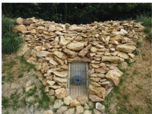
Installation de l'ouvrage de régulation et aménagement de la surverse de sécurité
