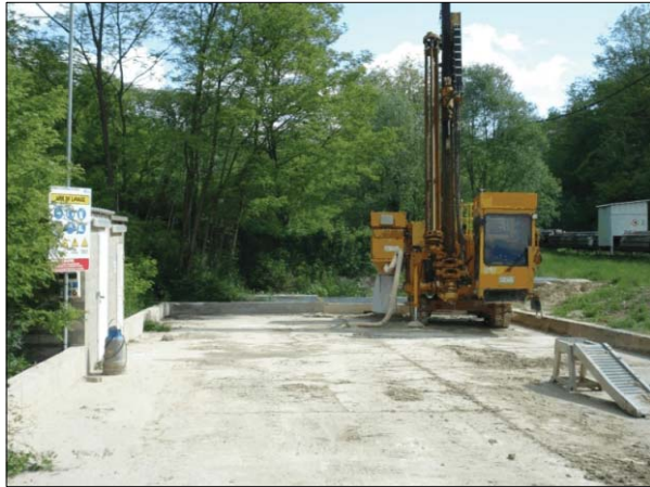
1) Aire étanche de lavage et de stationnement
