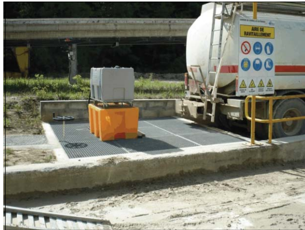
4) Rétention de l'aire de ravitaillement
