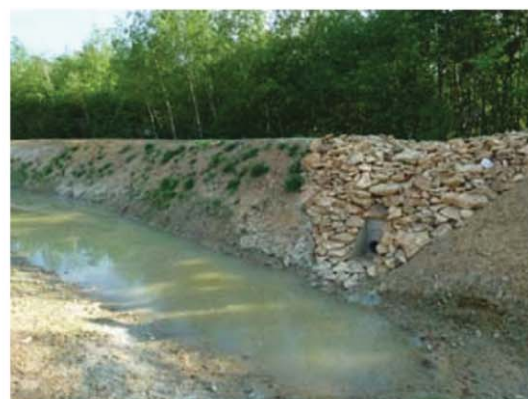
Installation de l'ouvrage de régulation et aménagement de la surverse de sécurité
