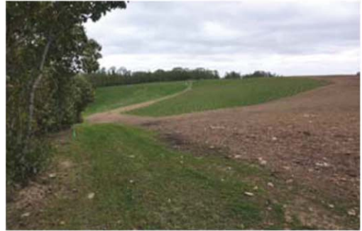
Engazonnement et raccordement au terrain naturel en ceinture de la carrière
