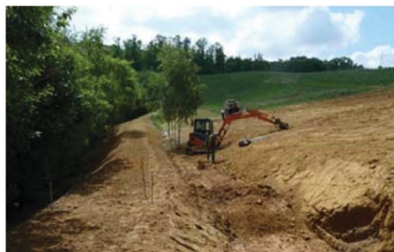
Collecte des eaux par des fossés et traitement par des fosses de décantation
