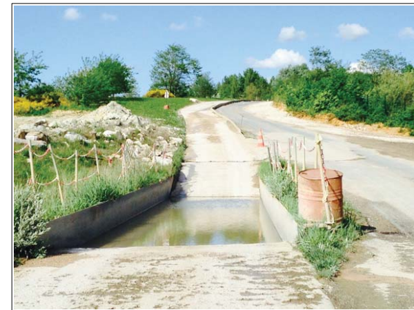
7) Décrotteur en sortie de la piste "terres extérieures" (lame d'eau en circuit fermé)
