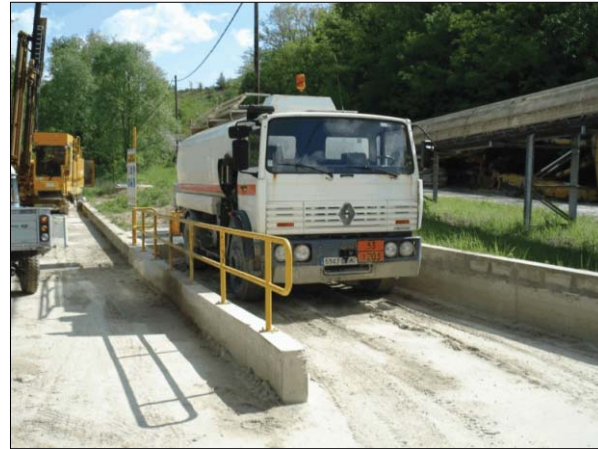
2) Aire étanche de ravitaillement
