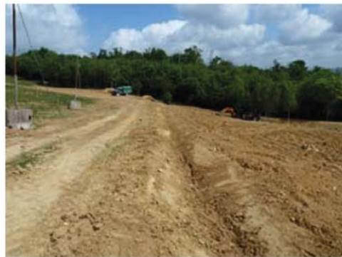
Collecte des eaux par des fossés et traitement par des fosses de décantation
