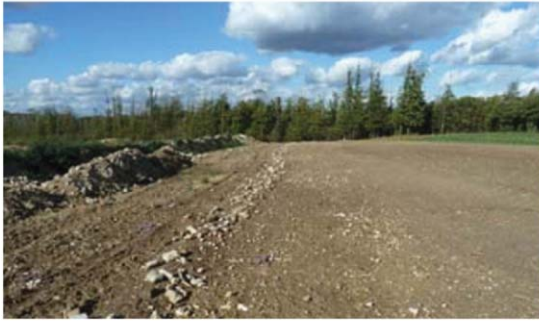
Passage de l'andaineur à cailloux avant engazonnement
