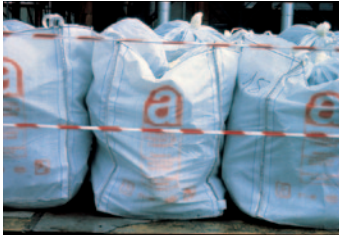
© INRS Déchets amiantés
