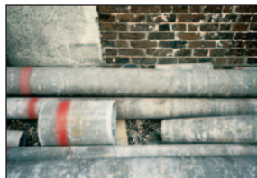
© INRS Canalisation en amiante
