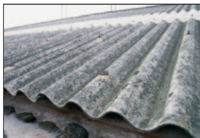
© INRS Toiture en amiante ciment
