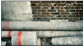
© INRS Canalisation en amiante ciment
