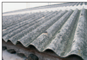
© INRS Toiture en amiante ciment
