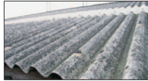
© INRS Toiture en amiante ciment
