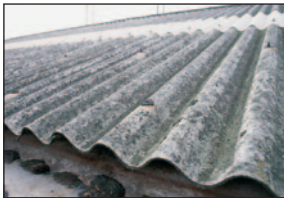
©INRS Toiture en amiante ciment
