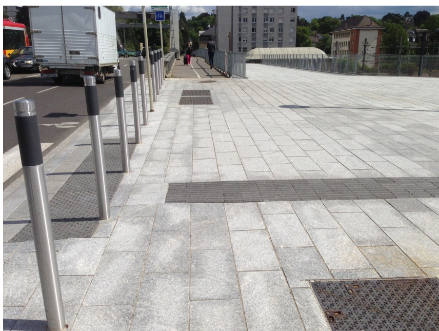
Illustration 15 : Interception sur le cheminement principal sans guidage menant à une traversée piétonne.
