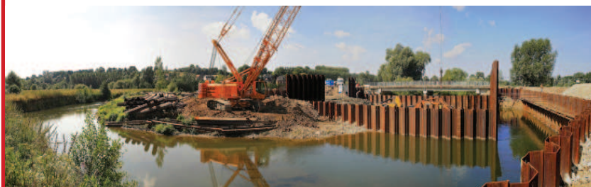
Travaux de prévention du risque inondation : site d'écrêtement des fortes crues de l'Oise de Proisy (02) réalisé par l'Entente Oise Aisne et achevé en 2009.
