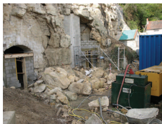
Confortement de falaises à Chars (95)
