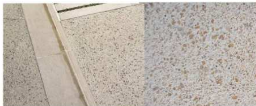
Cheminements piétonniers en béton désactivé – granulats clairs
